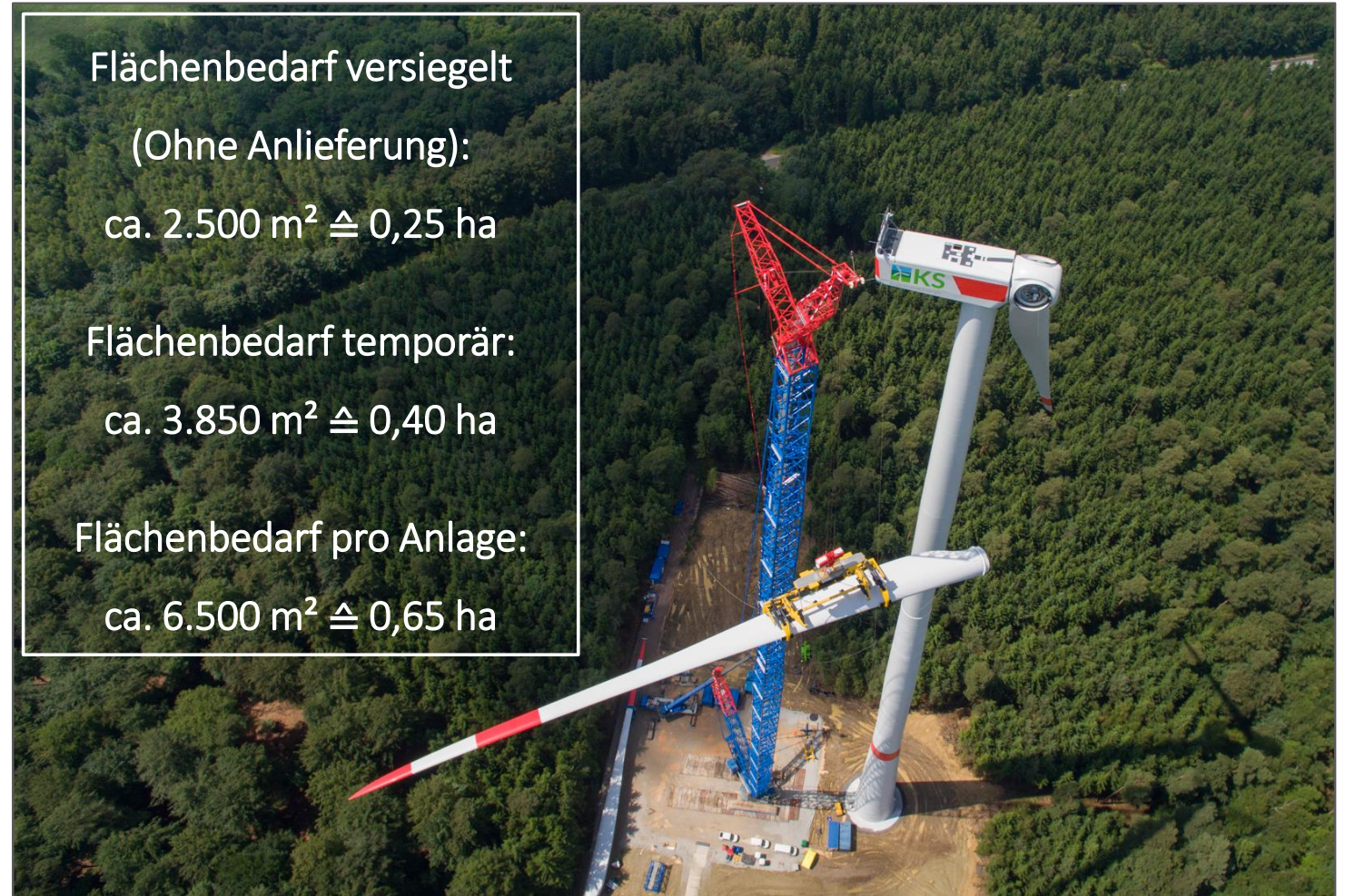
Abb. 17: Einzelblattrotormontage einer Nordex N131 mit 164 m Nabenhöhe im WP Bickenbach
