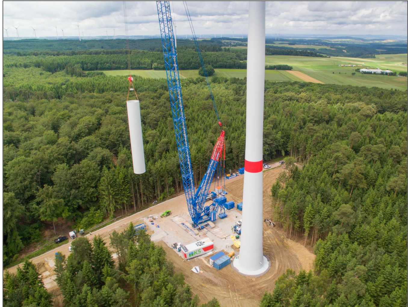
Abb. 16: Turmaufbau einer Nordex N131 mit 164 m Nabenhöhe in Bickenbach
