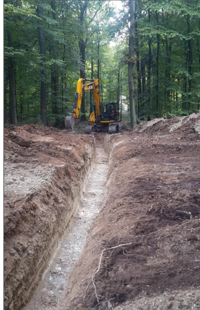
Abb. 19: Aushub eines Graben zur Verlegung der Netzkabel
