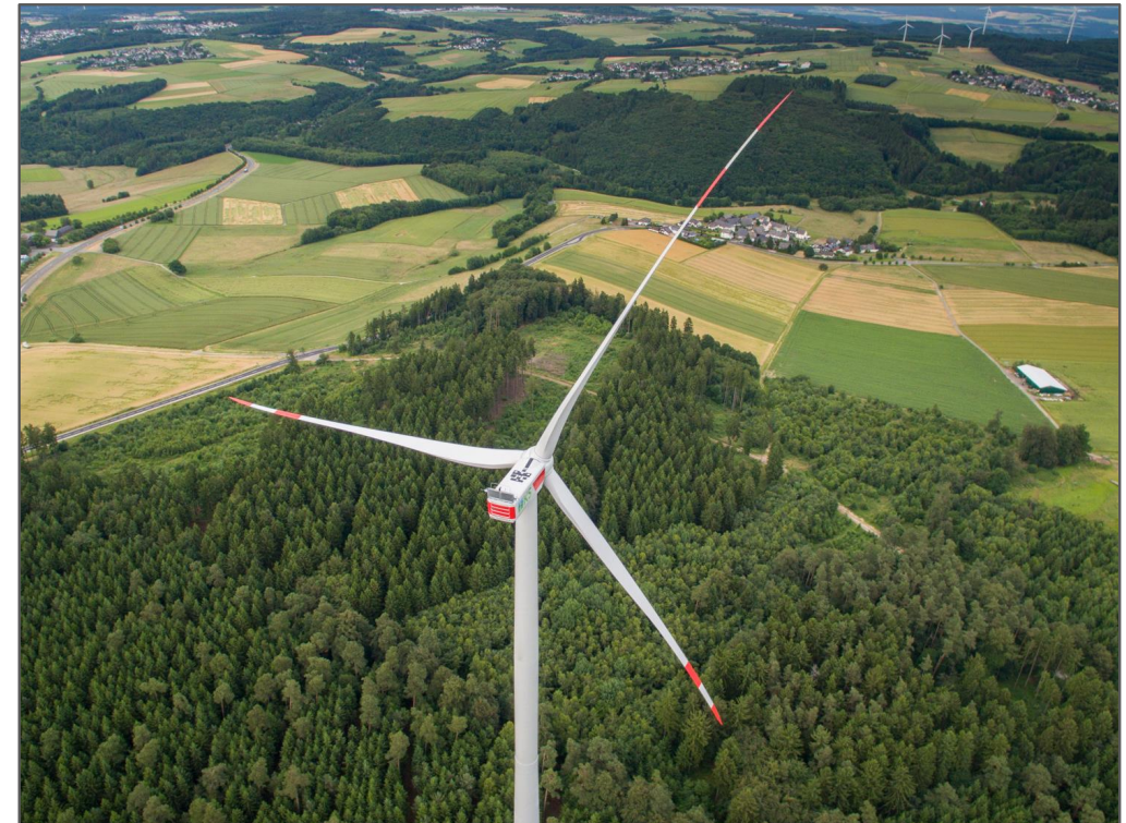
Abb. 2: Drohnenaufnahme einer Nordex N131, Nabenhöhe 164 m, Windpark Bickenbach
