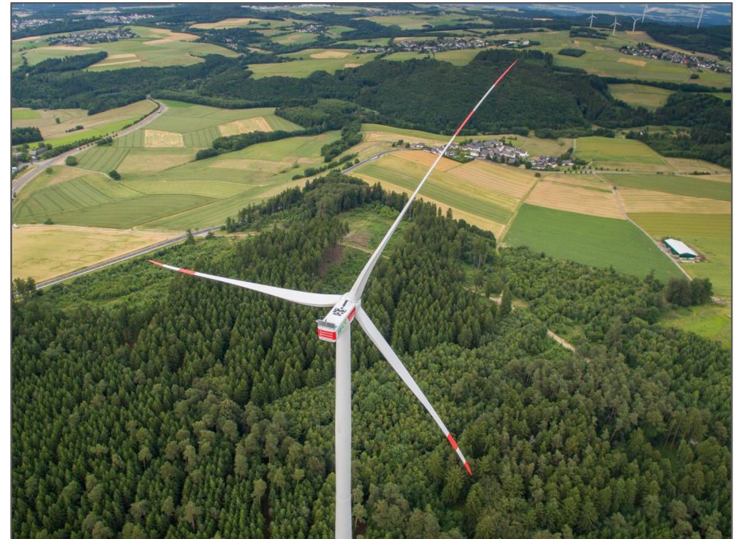
Abb. 3: Drohnenaufnahme einer Nordex N131, Nabenhöhe 164 m, Windpark Bickenbach
