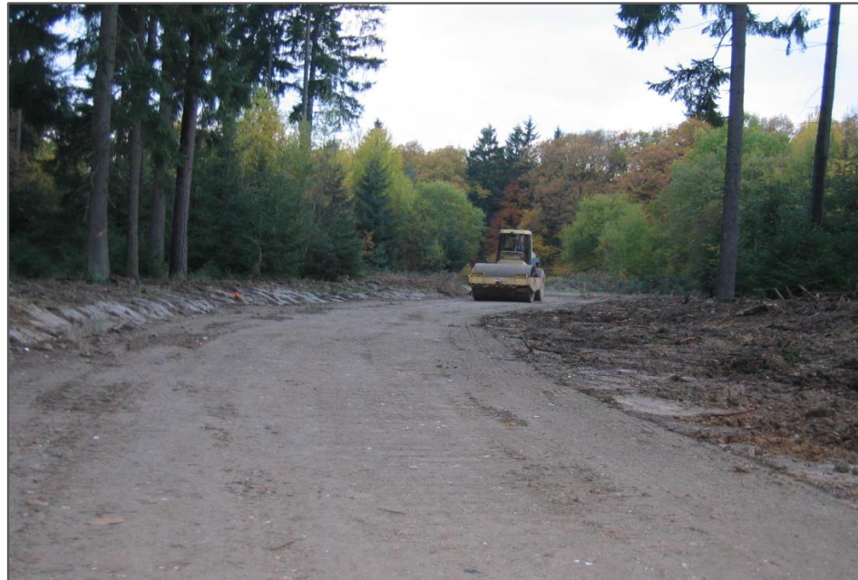
Abb. 14: Ausbau und Befestigung der Waldwege
