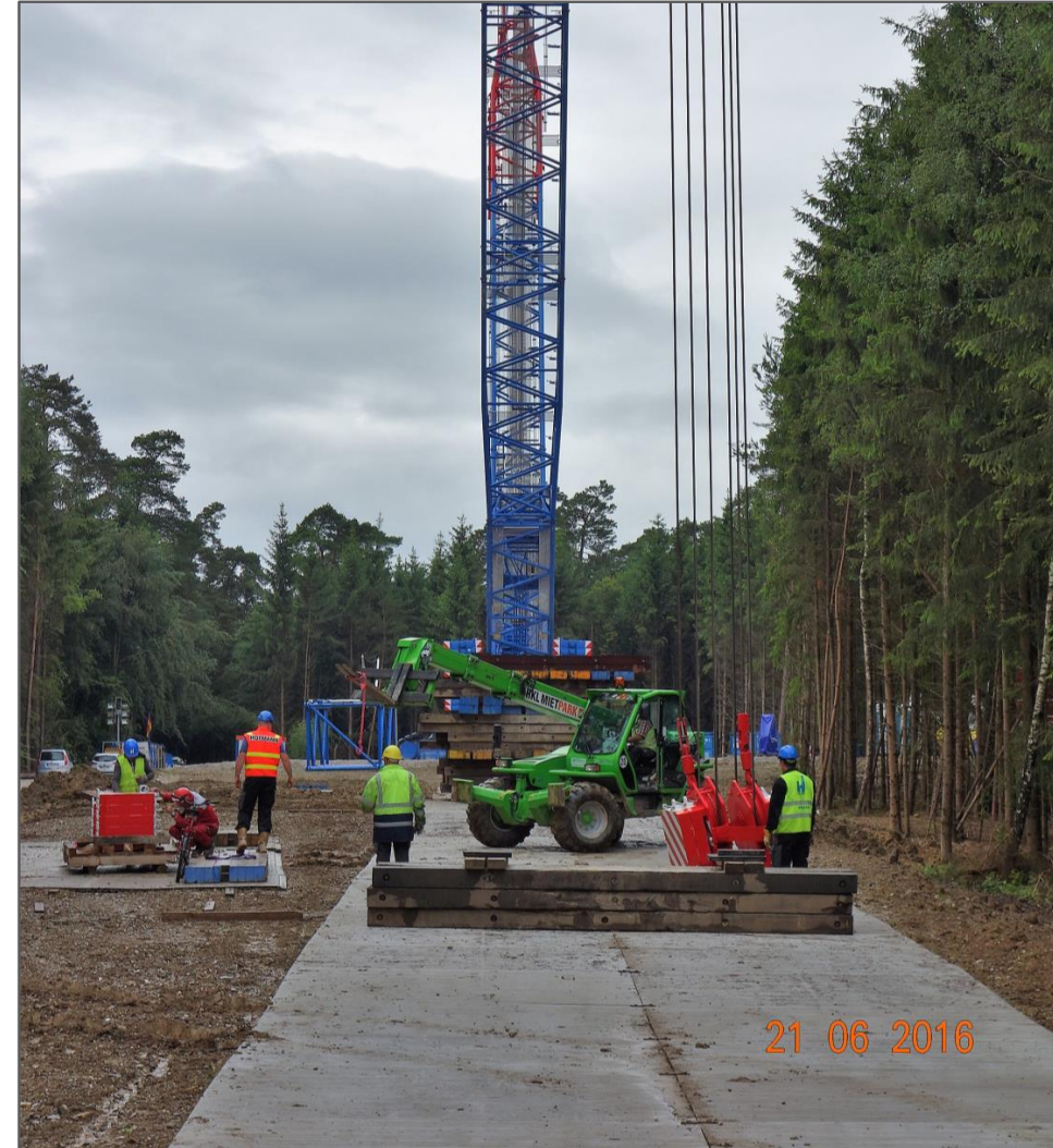
Abb. 13: Einsatz von Temporären Blechstraßen
