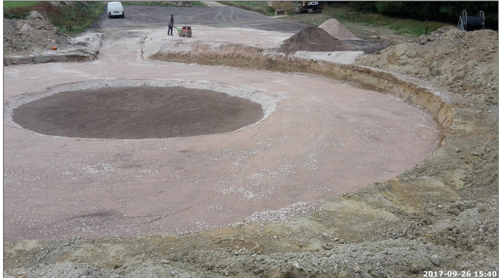
Abb. 11: Vorbereitung und Verdichtung des Bodens für den Bau des Fundaments einer Nordex N131 mit 164 m Nabenhöhe
